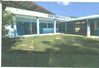
Foto1: Estructura tipo pórtico para área de Reuniones / usos múltiples.
